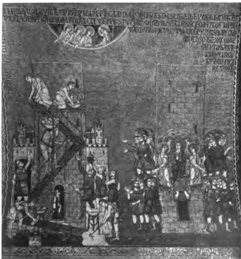
Fig. 247. — Construction de la tour de Babel. Mosaïques de Saint-Marc (Phot. Alinari).
